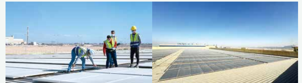
巨石埃及建设光伏发电项目
